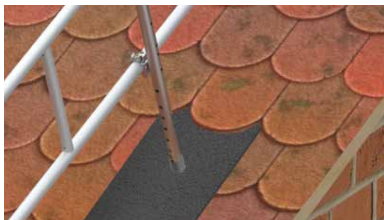
Protection antichute pour la rive du toit avec manchette.
